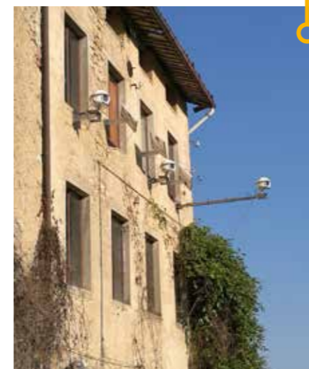
Figura 5 Sistema di monitoraggio a 3 fotocamere, installato su un casolare antistante la frana
